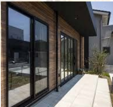
Рис 4. Опорядження фасадів деревом.
