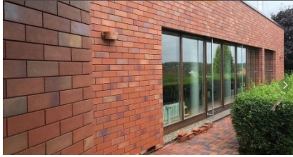
Рис.3 Обробка будівлі під цеглу.
