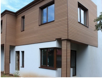
Рис. 5 Опорядження фасадів рейками.
