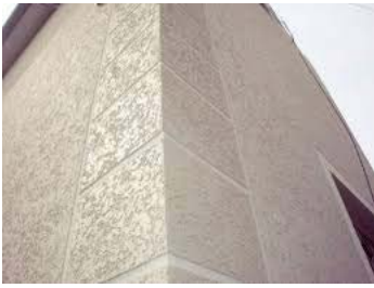
Рис.1 Опорядження фасаду штукатуркою коройд .
