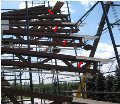
Мал. 7. Реалізація пластинчастих гасників коливань на сталевих фермах центрального входу.
